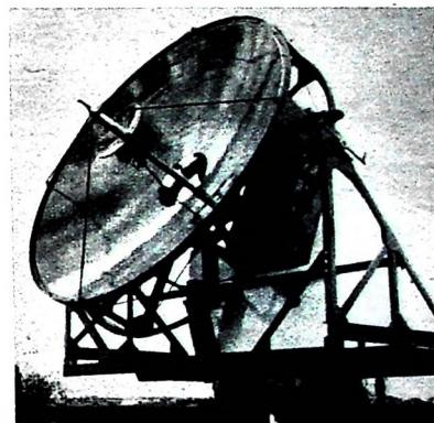
Der Hillsspiegel der Antenne ist entlang der Antennenzuführspire herausgedreht; der HF-Teil befindet sich in dem Gehäuse hinter dem Hauptantennenspiegel
